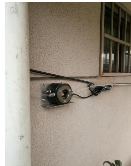
房屋沉降测量
