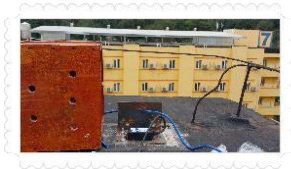
房屋倾斜自动化测量
